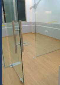
安装会客室玻璃门
