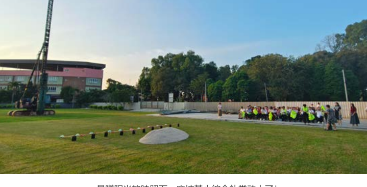
晨曦阳光的映照下，麻坡基小综合礼堂动土了！
