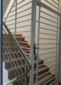
安装三楼铁花
