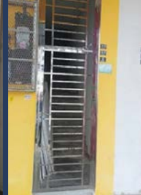
安装底楼钢门
